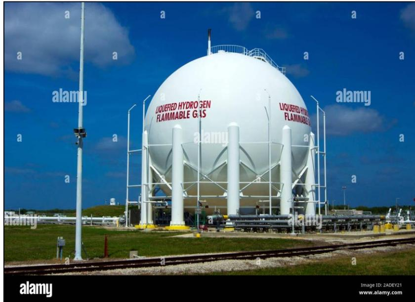
Figure 2.4 Un grand réservoir de stockage pour l'hydrogène liquide comme carburant de fusée de lancement au 39B au Centre spatial Kennedy [22]
