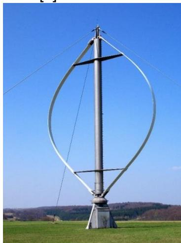
**Figure I.4** Eolienne de Darrieus
