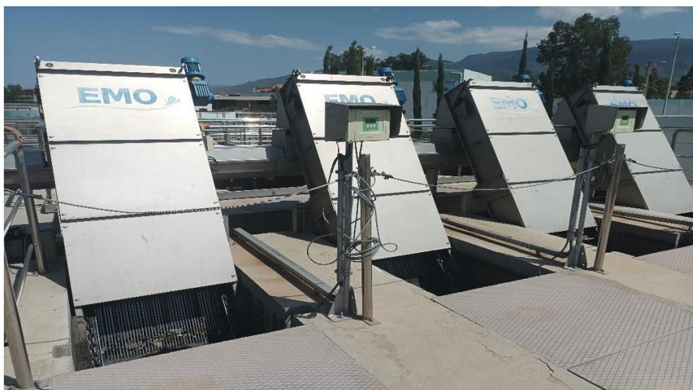
**Figure 1.6 : dégrilleurs fins**
