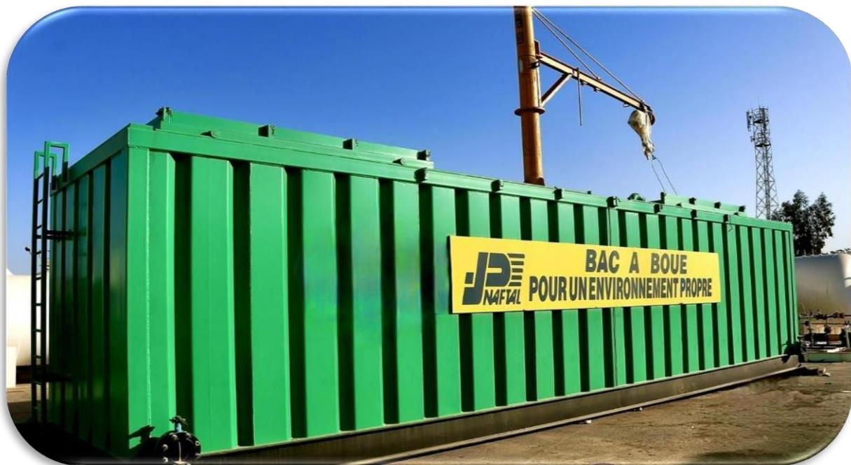
Figure II. 2: Bac de stockage des boues.
