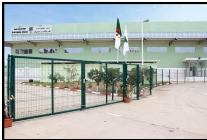
Figure 8: vue sur la zone de production saidal.
