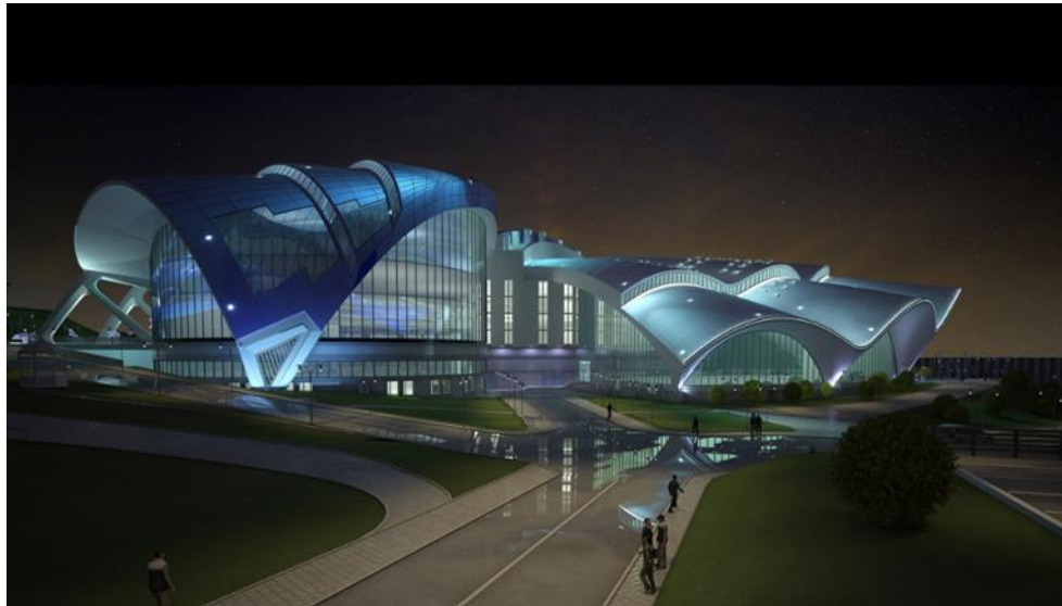
Figure 39 : Vue sur le projet
