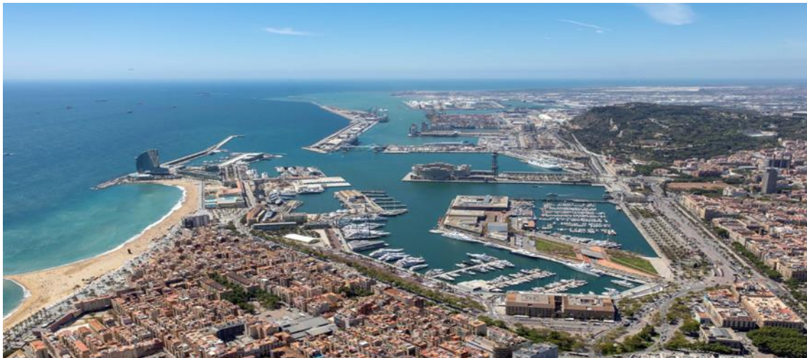
Figure 11 : Vue sur le port de Barcelone
