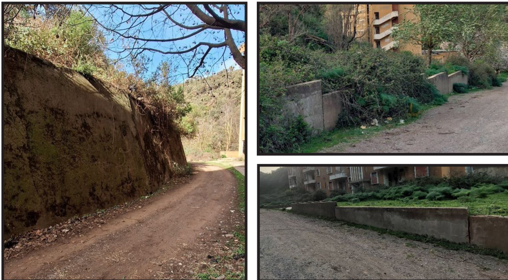
Figure 67: Les voiles en gabionnage
