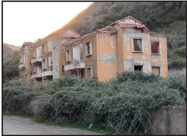
Figure 65: Les logements d'astreinte
