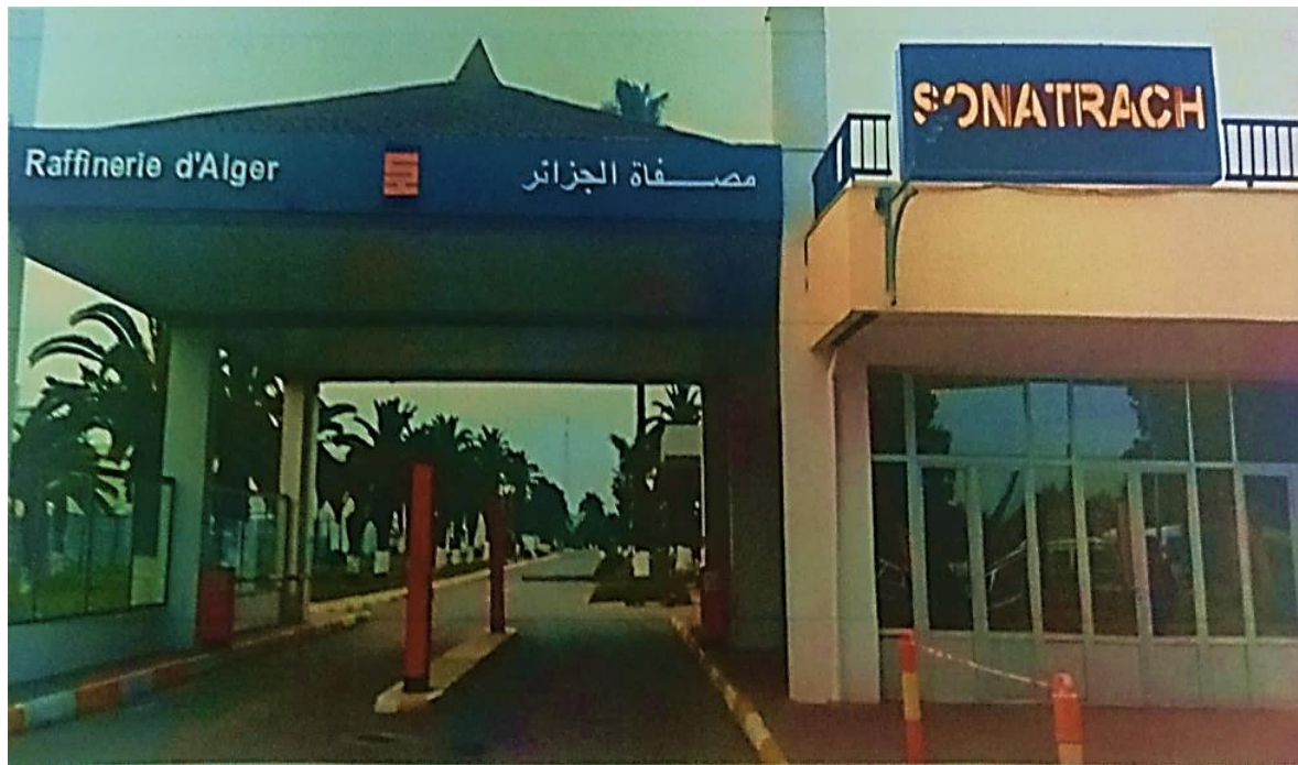
Figure 2.1 : Entrée principale de la raffinerie d'Alger.
