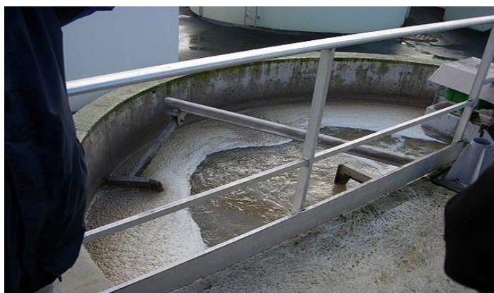
Figure 11: l'opération de dégraissage.
