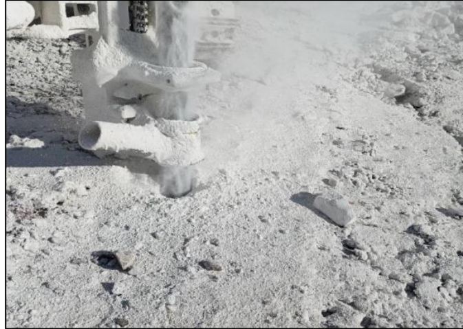
Figure III.1 : Opérations de forage à El Madjen.
