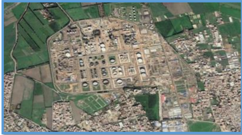
Figure II.1 : Vue aérienne de la raffinerie d'Alger
