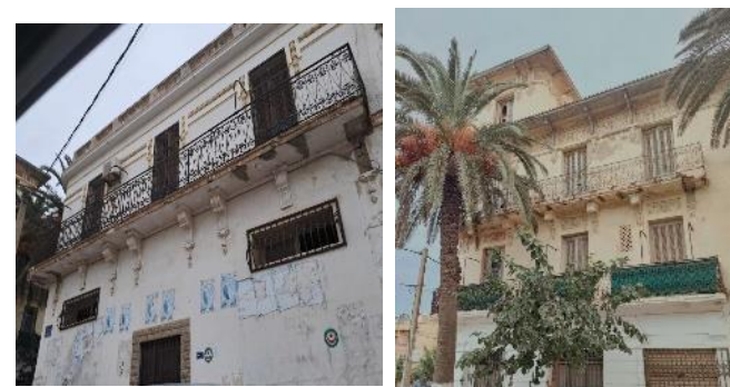
Figure 52 : bâti en moyen état photos prises par l'auteur
