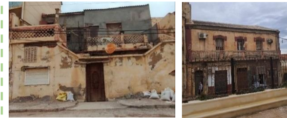
Figure 53 : bâti en mauvais état photos prises par l'auteur
