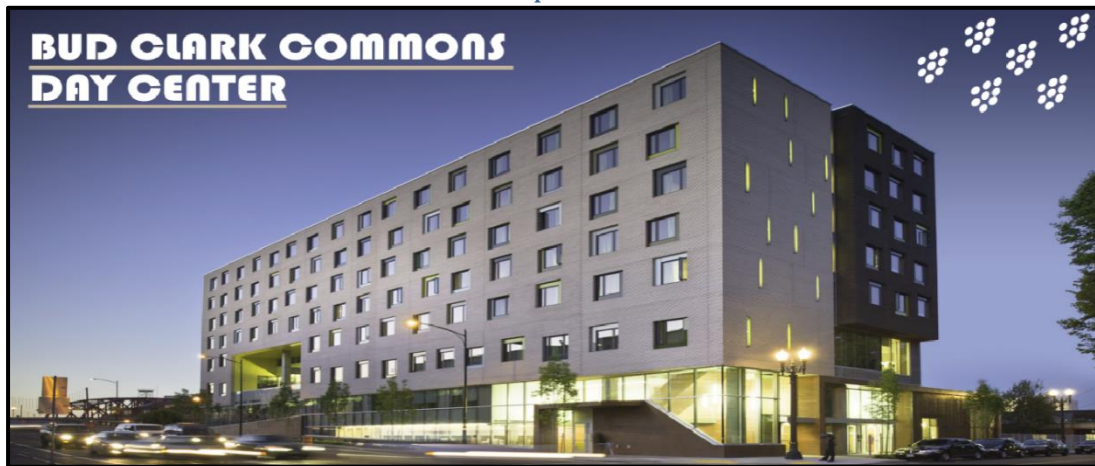
FIGURE 2 : BUD CLARK COMMONS - PORTLAND – USA
