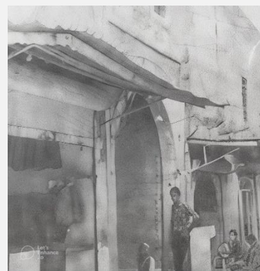
Figure 98: l'entrée du Qaisaria d'Al-Attarin source : www.uomosul.edu.iq
