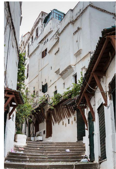
Figure 105: Maisons à encorbellement de la Casbah d'Alger source : google image
