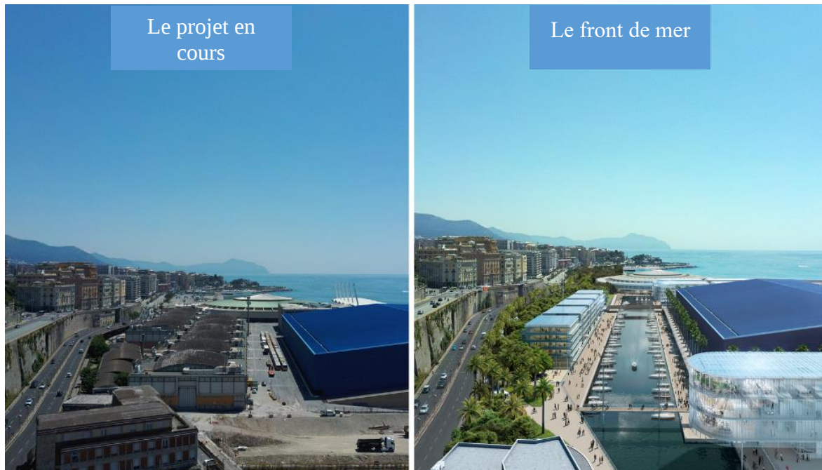
Figure 40: le front de mer de la ville de gène en cours de réalisation source : www.archdaily.com
