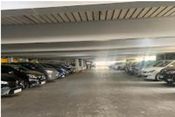
Figure 132: poutre du parking à étages (Google)
