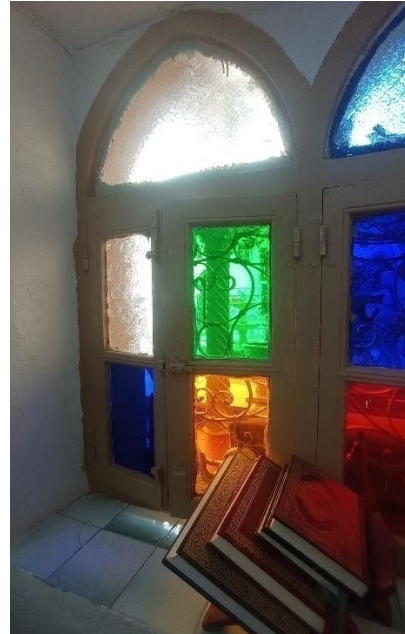
Figure N° 05 :Les mêmes fenêtres de l'intérieur_ une maison traditionnelle_ Blida Source Auteur, 2025
