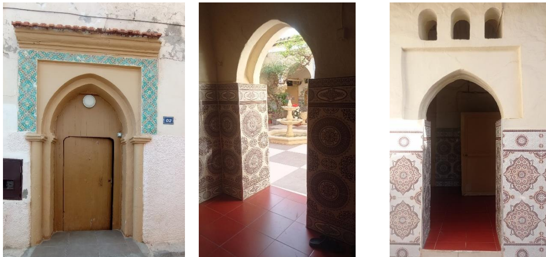
Figure N° 03 : Porte d'entrée et arc de Skifa dans une maison traditionnelle_ Blida Source Auteur 2025
