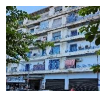
Figure 60: bâti coloniale. Source : prise par auteur
