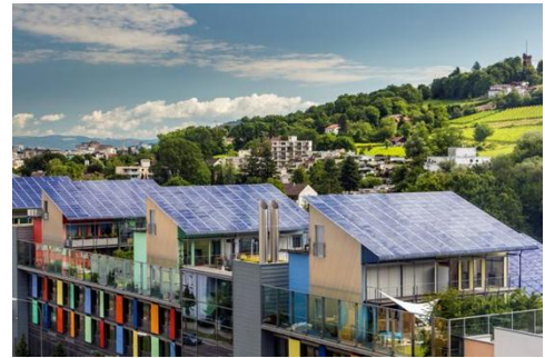
Figure 9: Panneaux photovoltaïques. Source : association écoquartier
