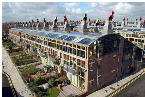
Figure 21: Quartier Bedzed ; Source : association écoquartier
