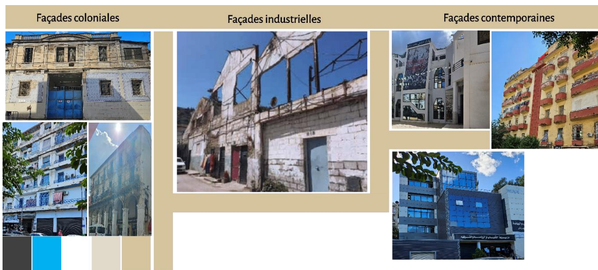
Figure 93: façades el Hamma. Source : photos prises par auteurs
