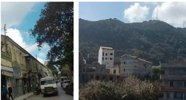
Figure 53 : Photos d'état de bâti de Dellys. Source : auteures
