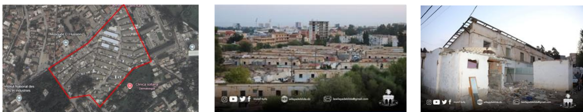
Figure 1: Photos montrant les bidonvilles de 19 juin avant et durant la démolition. Source: réseaux sociaux.
