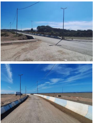
Figure 80: une voie tertiaire menant à la mer. Source : auteures, 2025.
