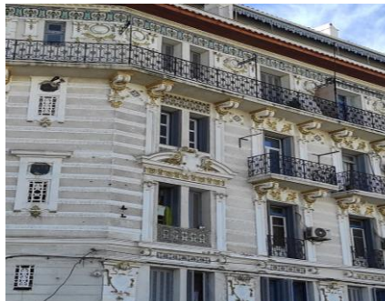
Figure 69: Façade d'un bâtiment colonial.
