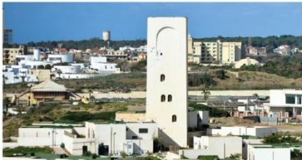
Figure 197: Vue sur la tour. source: auteurs, 2025.
