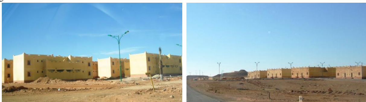
Figure 36 : Photo des habitations des nouvelles extensions à Ghardaïa
