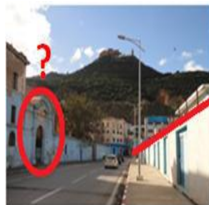
Fig.I.6 la négligence des monuments historique (patrimoine délaissée).
