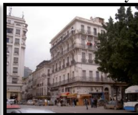
Fig III.53 Ancienne mairie Source : prise les auteurs de mémoire
