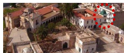
Fig III.94 : Types de toitures du palais du bey.
