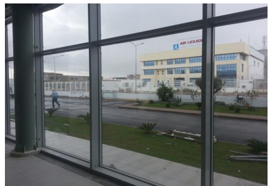
Fig.15 matériaux de construction
