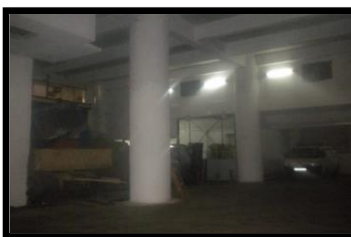
Fig III.79 Espace de stationnement ; Source : idem
