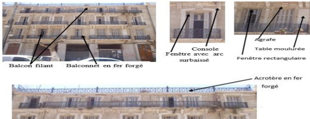
Fig III.70 caractéristique de la façade de l'immeuble N° 5. Source : traité par les auteurs de mémoire
