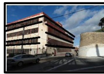
Fig III.82 La Partie nouvelle, (partie construite en 1959): elle est composée de sept niveaux (R+6). Avec une façade typique de l'architecture industrielle et des ouvertures en bandes.
