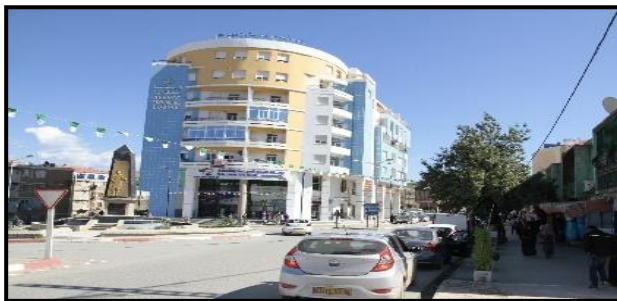
Figure 28: le projet en chantier
