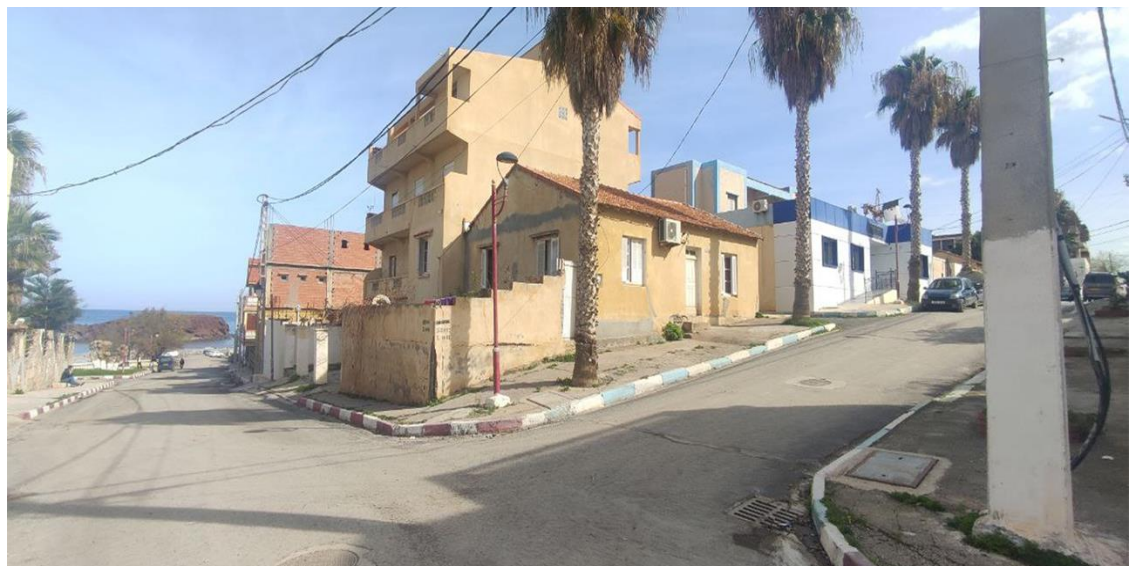
Annexe 22 La voirie de l'ancien tissu
