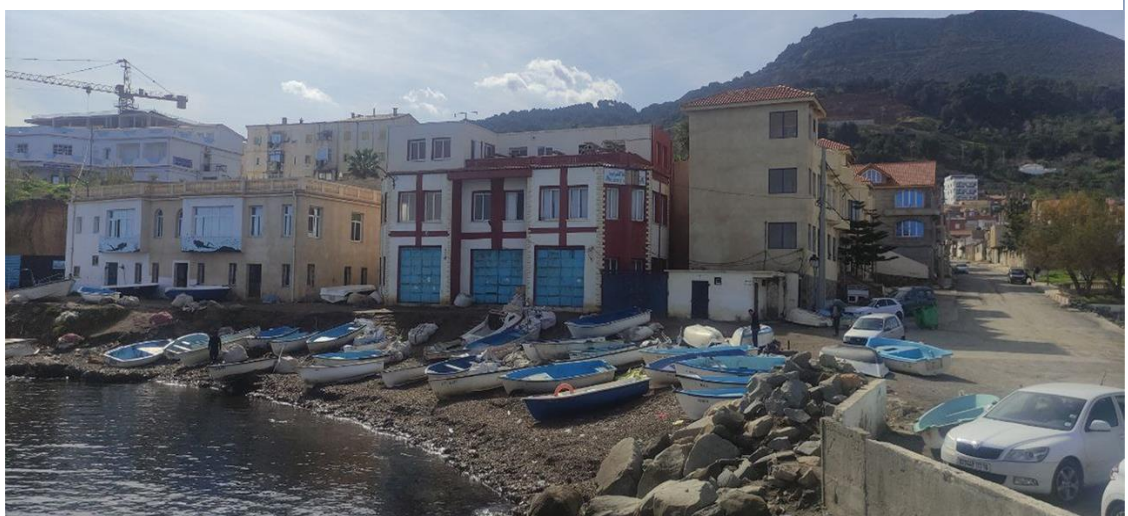
Annexe 24 La voirie de l'ancien tissu
