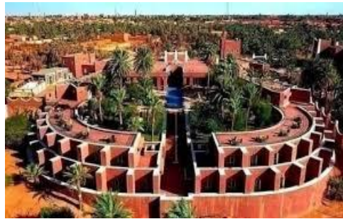
Figure 151 : hôtel Gourara Timimoune , Source https://fr.hotels.com/ho3327099200/gourara-hotel-timimoune-algerie/
