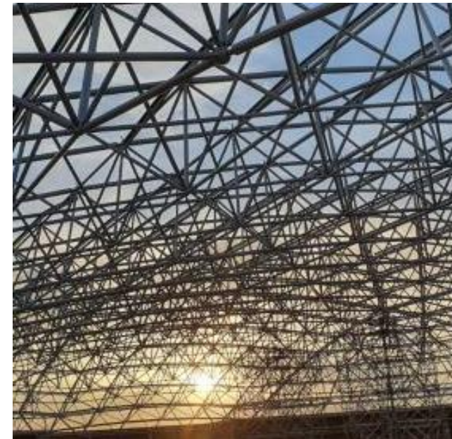
Figure 169: Toiture métallique tridimensionnelle, Source https://www.lanik.com
