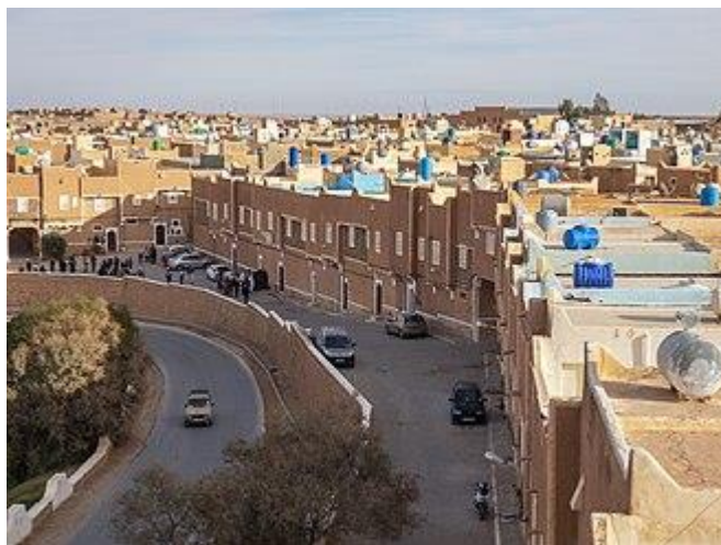
Figure 35 : Vue de Tafilelt depuis sa tour source : google image
