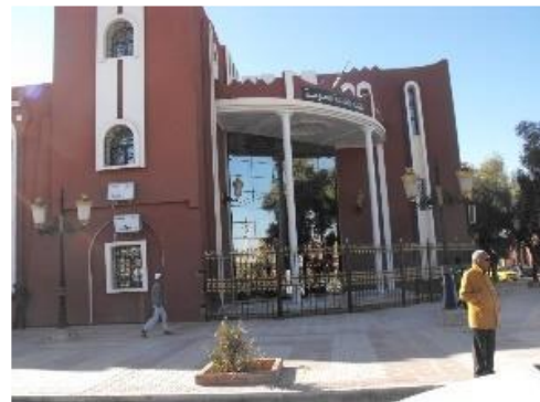
Figure 67 : Bibliothèque d'Adrar, Source : google image
