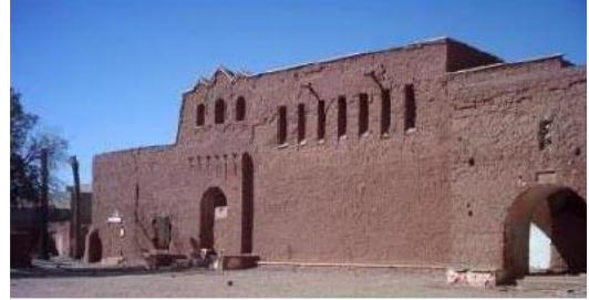
Figure 66 : L'Ancien Hôpital d'Adrar de l'architecte Michel Luycks, source : google image
