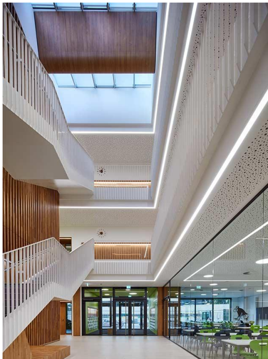
FIGURE 130 : LONGLIGHTS AU-DESSUS D'UN ESCALIER D'ÉCOLE PRIMAIRE; SOURCE: VELUX COMMERCIAL, NOUVEAU BÂTIMENT SCOLAIRE À DRESDE
