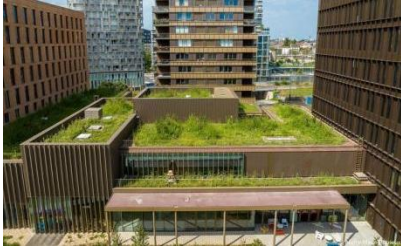
FIGURE 106 : TOITURE VÉGÉTALISÉES, ILOT 4B À NANTES ; SOURCE : PINTREST
