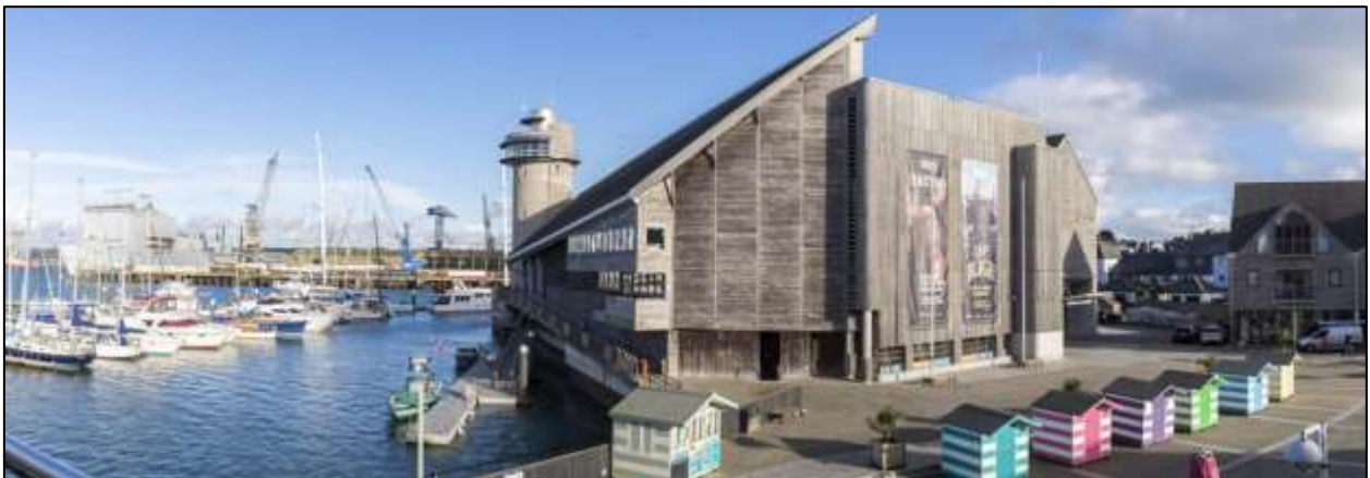
Figure 73: Vue de la façade ouest et Nord
