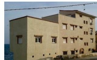
Cette partie qui se trouve à proximité du noyau initial contient de l'habitat, un atelier de mécanique-auto, parking de bateaux. La majorité des constructions sur cette partie sont en mauvais état (façades dégradées, structure en parpaing, murs fissurés), le gabarit en RDC ou R+1. On signale trois immeubles qui sont en bon état, c'est des constructions récentes modernes qu'on va intégrer dans notre projet.
