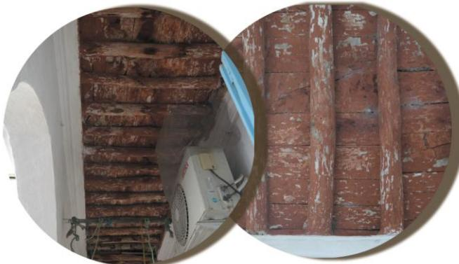
Figure 141: Plancher en rondin.
