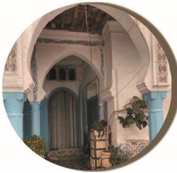
Figure 158: Arc ogive lancéolé . Source : Auteur
