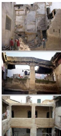
Figure 28: Consolidation du bâti menaçant ruine.
