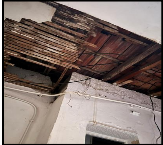
Figure 99: Plancher : En bois damé de terre et de chaux
