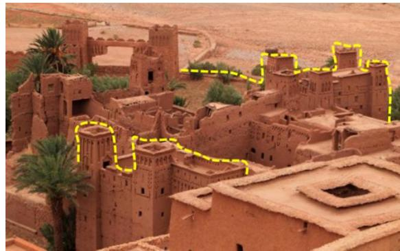
*Figure 13: différence des hauteurs et platitudes des toits du Ksar*
