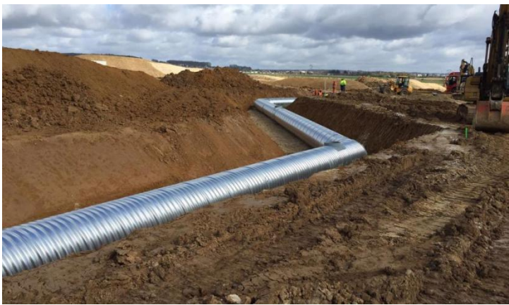
FIGURE 52 CANALISATION SOUTERRAINES; SOURCES: CANALISATION EN ACIER GALVANISÉ POUR LA GESTION DES EAUX PLUVIALES
