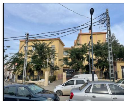
Figure 101: L'école sidi yakhlef Source : par l'auteur.
