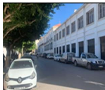
Figure 85: Lycée Ibn Rachid. Source : auteur.
