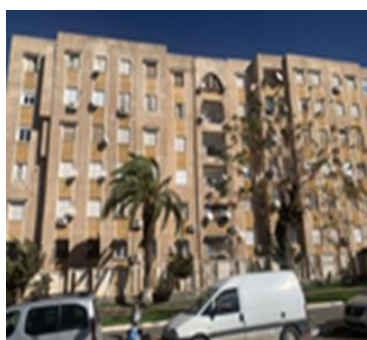
Figure 80: Lycée Ibn Rachid. Source : auteur.
