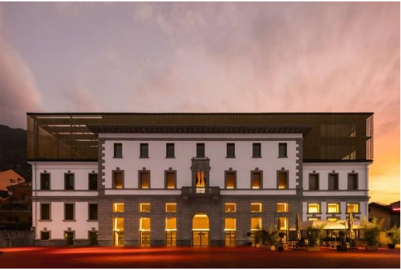
Figure 42: la façade principale de projet de Plazzo
