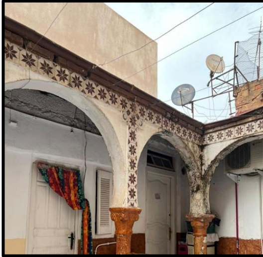
Figure 145:vue sur le patio
