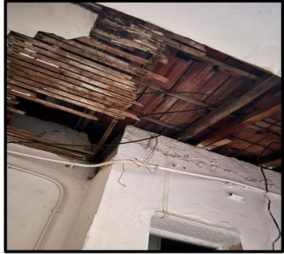
Figure 146:Plancher : En bois damé de terre et de chaux
