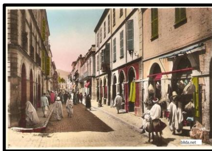
Figure 85 : Avenue de la gare de Blida
