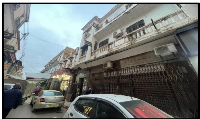
Figure 170:Exemple de façades de la rue des martyres
