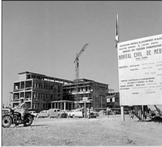
Figure 47 : Construction de l'hôpital civil de Médéa dans le cadre du plan de Constantine Source: archives de la wilaya de médéa
