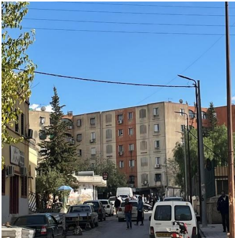
Figure 50 : l'ensemble d'habitat collectif de la cité du 24 février source : auteurs
