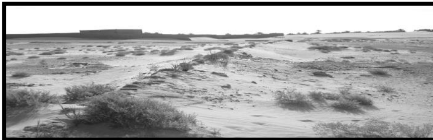
Figure 33 Seguia (canal) de la foggara Outakou (Timimoun) couverte de roches plates (REMINI, 2008).
