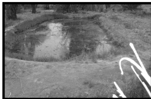
Figure 35 Un Madjen (un bassin de stockage) dans une palmeraie de Timimoun (REMINI, 2008).
