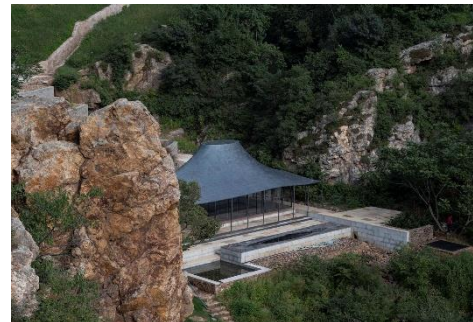
Figure 12 : Cloître supérieur Source : Archdaily
