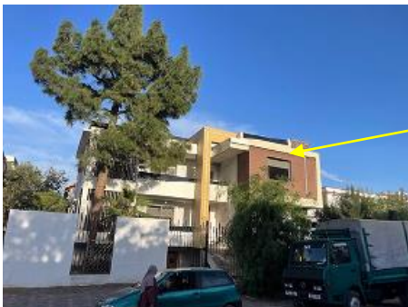
Figure 151 : Villa moderne à cité Naimi Source : Auteure
