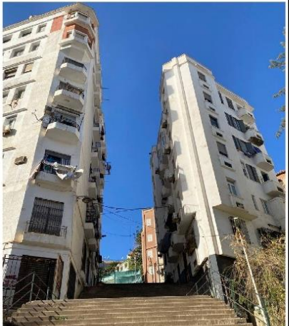
Figure00:immeuble en moyen état. source:photo prise par les auteurs
