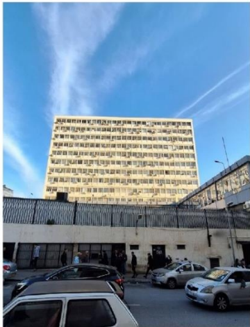
Figure : immeuble en R+12 Source : prise par les auteurs.
