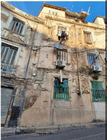
Figure : immeuble en R+2 Source : prise par les auteurs.
