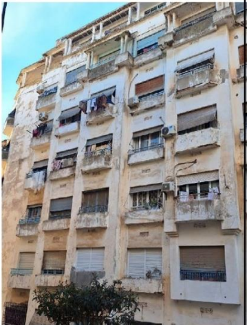
Figure : immeuble en R+6 Source : prise par les auteurs.
