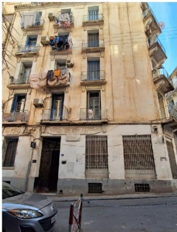
Figure : immeuble en R+3 Source : prise par les auteurs.
