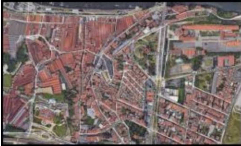
Figure 7: l'état actuel de l'ilot
