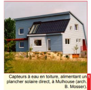
Figure 28: les plancher solaire
