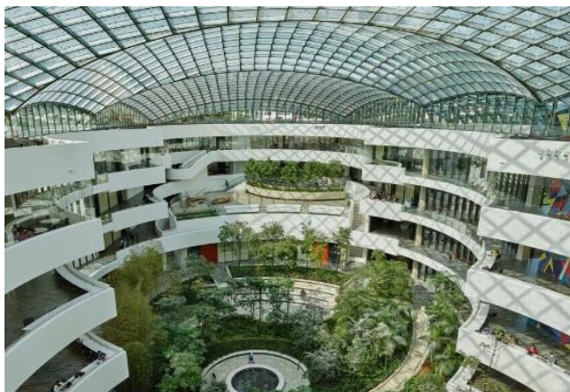
Figure 101 : Atrium végétalisé. Source : Archdaily
