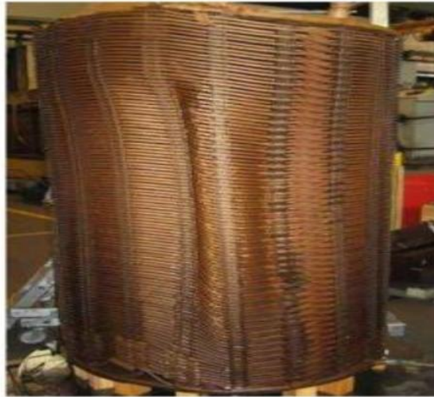
Figure I.13 Déformation mécanique d'un Enroulement [11]
