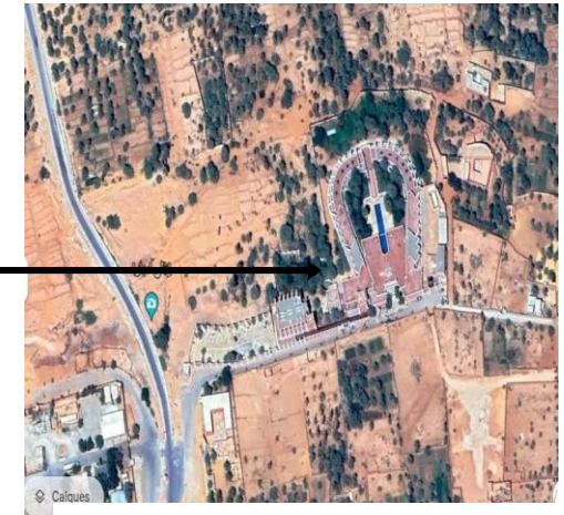
Figure 57:vue de l'hôtel, source : Google
