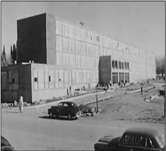
Figure 42 : Le siège de la préfecture, actuellement Lycée Fekhar Source: archives de la wilaya de médéa
