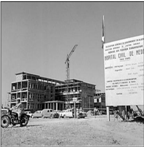
Figure 43 : Construction de l’hôpital civil de Médéa dans le cadre du plan de Constantine Source: archives de la wilaya de médéa
