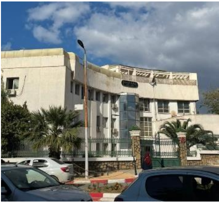
Figure 47 : photo actuelle sur le siège de la daira de medea source : auteur.
