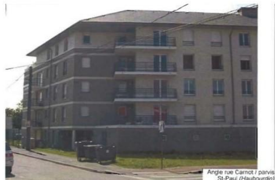
Figure 11 : immeuble plot Source: VANDERHEEREN. (2006). Patrimoine urbain remarquable du Nord : Typologies, pp.66
