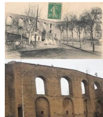
Figure 56: vue ancienne et actuelle sur les aqueducs romains
