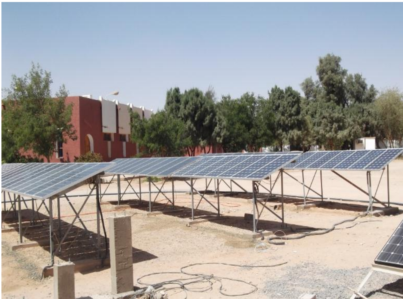
Figure 4.1 : Extension du générateur PV à 4575 Wc formé de 03 rangées et de deux sous générateurs PV SGPV 1 et SGPV 2
