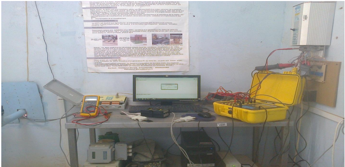
Figure. 4.15 : Vue du banc d'essai expérimental avec le branchement du Grenntest FTV 100 sur le convertisseur DC/AC Lorentz PS1800
