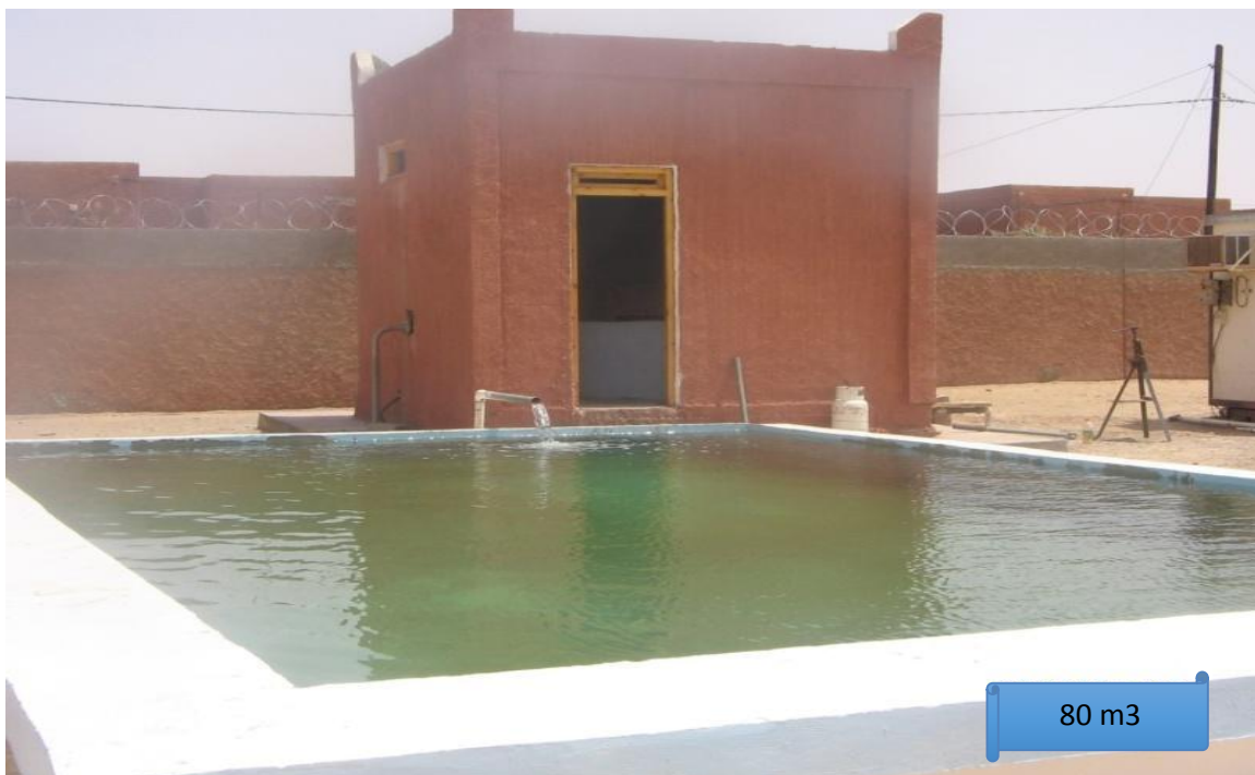
Figure 4.4 : Abri puits et un bassin de stockage d'eau de 80 m 3
