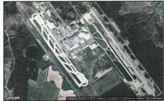
Figure 54 : Vue postérieure L'aéroport international Domodedovo source : Google Earth
