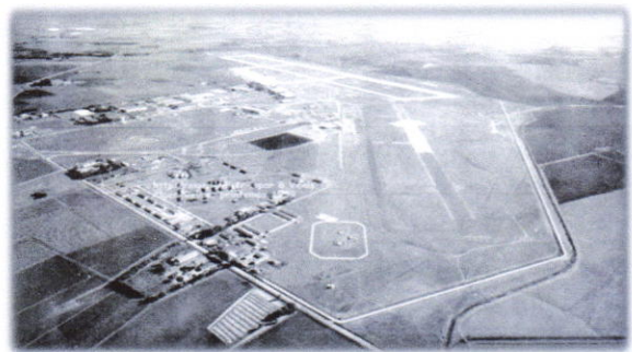
Figure 58 : Vue aérienne de l'aéroport de maison blanche 1955
