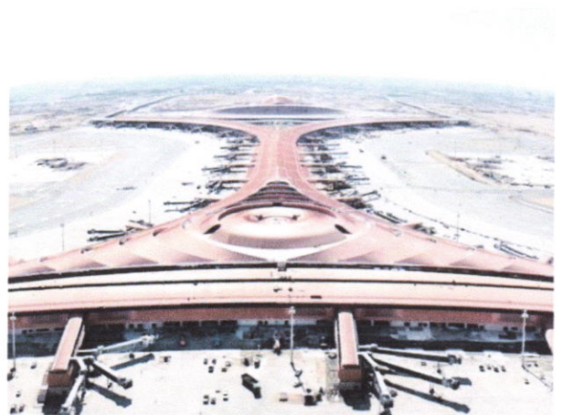
Figure 39 : Vue postérieure de l'aéroport King Abdelaziz source : Google Earth.
