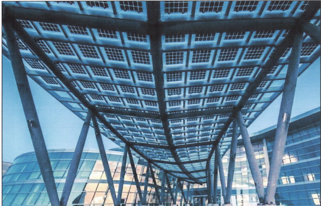
Figure 124 : Panneaux photovoltaïques semi-transparents intégrés - Source : https://www.arch-products.com/
