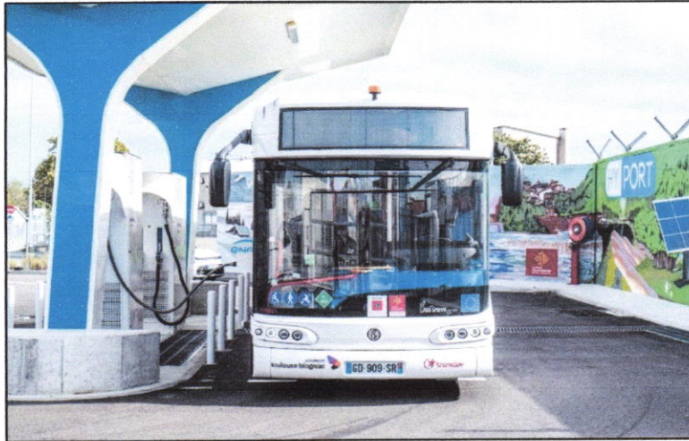
Figure 9 : La station hydrogène de l'aéroport de Toulouse-Blagnac, Source : https://www.h2-mobile.fr/
