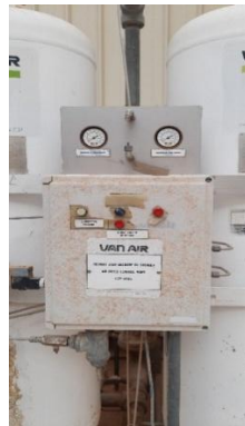
Figure II-19 : Vue extérieure d'armoire
