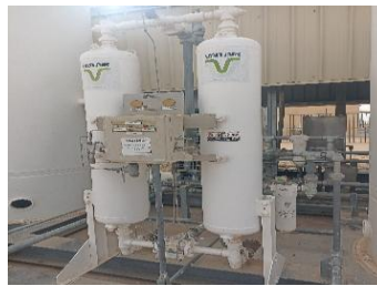
Figure II-15 : Sécheur d'air comprimé régénératif sans chaleur VAN AIR HL-500s
