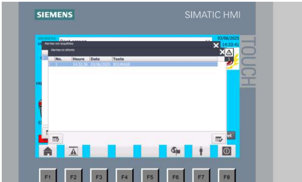
Figure 3. 12: SUPERVISER LA LARME DE BOURRAGE
