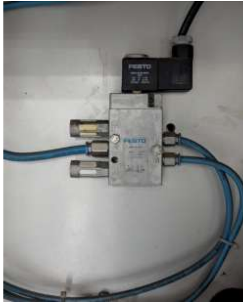
Figure 1. 6: DISTRIBUTEUR ET BOBINE FESTO [15]
