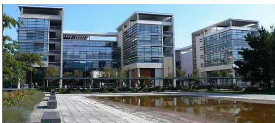
Figure 2.17: Bâtiments de la faculté des droits et sciences économiques
